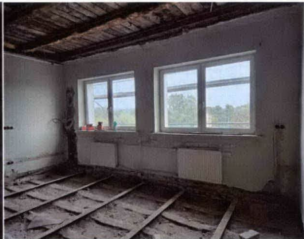
Zdjęcie 28: Prace budowlane w ZSOiT w Siewierzu
