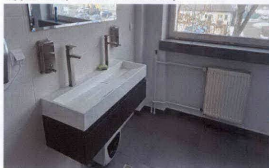
Zdjęcie 16 Wyremontowane toalety
