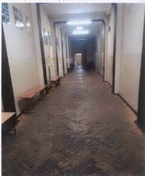
Zdjęcie 25 Korytarz szkolny przed remontem
