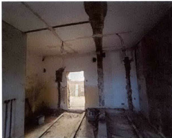
Zdjęcie 27 Prace budowlane w ZSOiT w Wojkowicach
