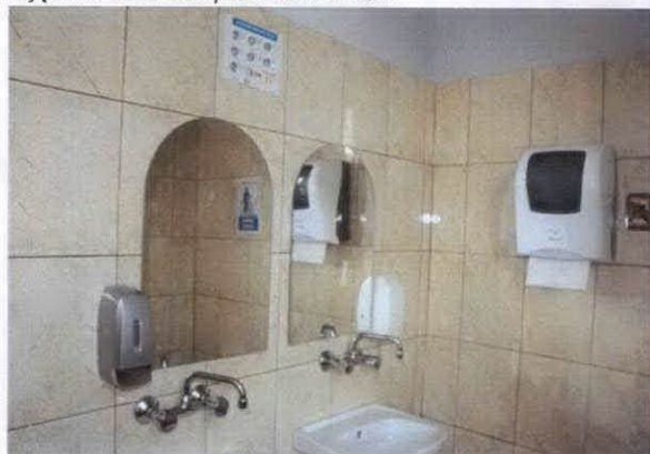
Zdjęcie 1 łazienka przed remontem
